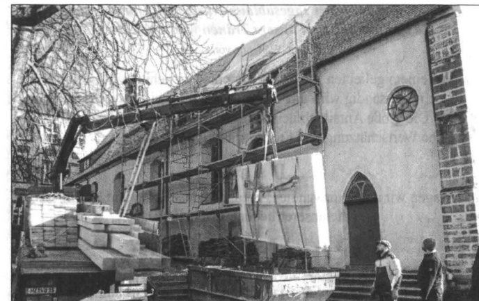
Das Dach der Schlosskirche wurde geöffnet, um die riesigen Teile auf die Empore zu verfrachten. Fotos: privat/cbo
